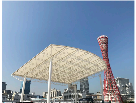
▲港にある新築の屋外ステージ。周辺には鳩や鳥が多く、ステージに内側梁に鳥が止まることが予想されたため、電気ショックを設置し鳥の待機を事前に予防しました。
