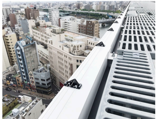
▲新築時に商業ビルの屋上に電気ショックを設置しています。周辺は大きな寺院があり、鳩が多い地域。鳩は高い場所に止まる習性があり、今後被害が予測されるため、事前に対策を実施。
